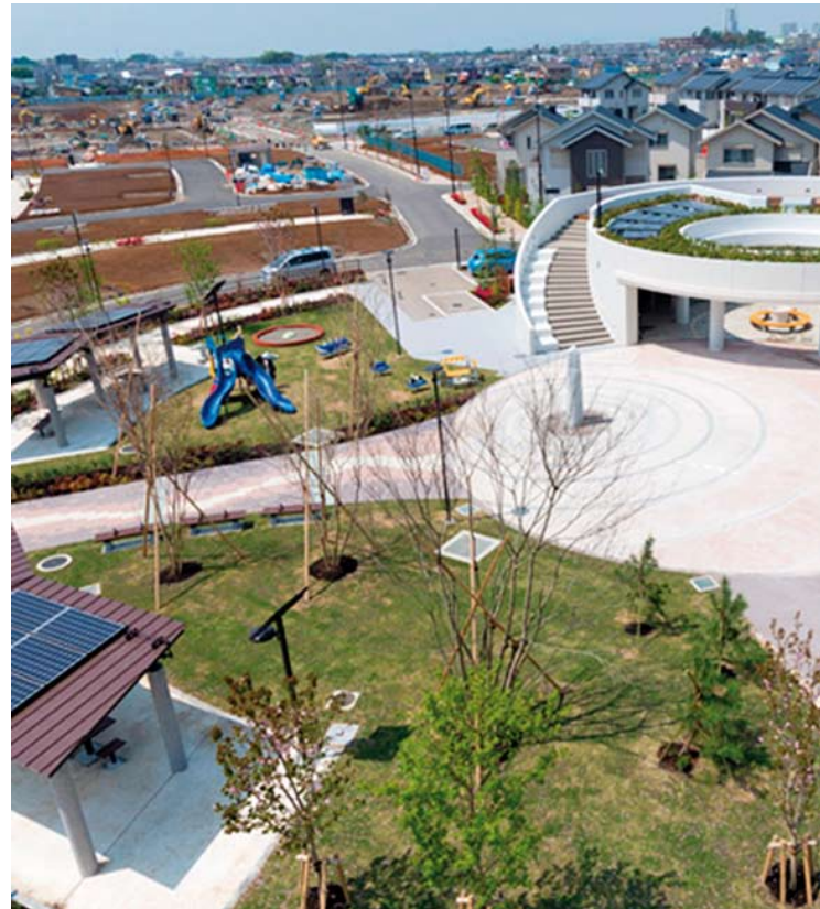
Rund 100 Personen finden bei einer Tsunami-Evakuierung Platz auf dem Gemeindedach im zentralen Parkgelände.
